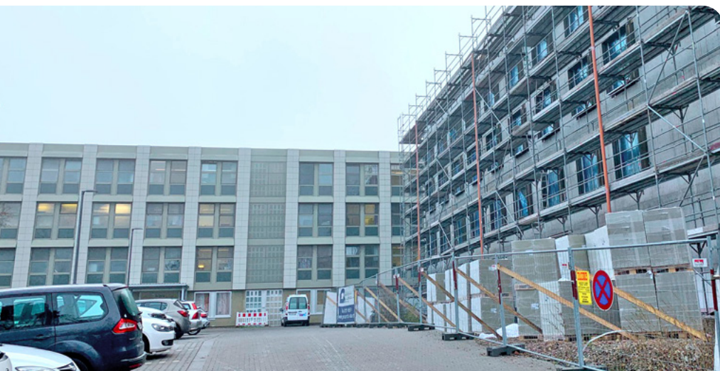
Der Neubau des Wilhelm-Griesinger-Hauses liegt derzeit im Plan. Die Bauarbeiten kommen gut voran.
